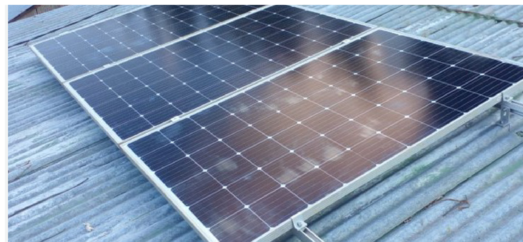
FONDATION AXIAN PhaGDis MAROLAMBO Fourniture et installation d'un Kit Solaire OFF-GRID 3 kVA 1 banc 190Ah
